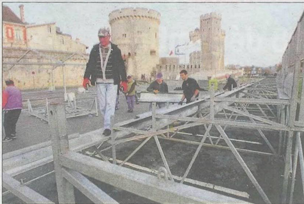
Joël Gorge, funambule sur la structure d'acier. PHOTO PASCAL COUILLAUD
